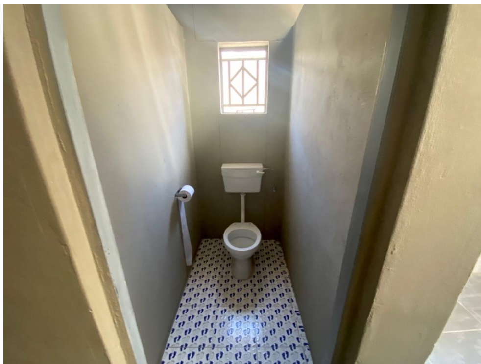
新しく建設された水洗トイレ（サヴォ・ナッツ私立学校）
